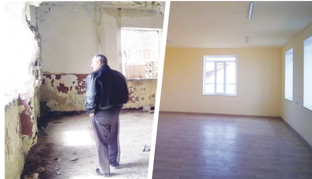
▲ La salle de danse avant / après les travaux
